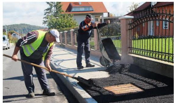
**U** Stubičkim Toplicama ugradnjom cestovnih rubnjaka i asfaltiranjem, produžen je postojeći nogostup u Ulici Ljube Babića Đalskog u dužini od oko 40-ak metara. Nastavak izgradnje nogostupa do granice s gradom Orlavljem, planiran je Programom gradnje objekata i uređaja komunalne infrastrukture tijekom iduće godine. (mlm) ■
