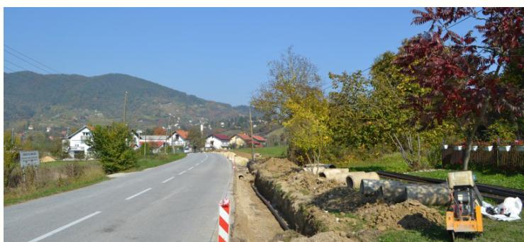
**U**tijeku su radovi izgradnje prve faze nogostupa uz županijsku cestu 2186 od ulaza za Lepoglavec prema Gredicama u gradu Klanjcu. Radovi uz kolnik na Radničkoj cesti obuhvaćaju izradu oborinske odvodnje ugrađivanjem PEHD cijevi i revizionih okana u dužini od 170 metara te izgradnju pješačke staze u ukupnoj
