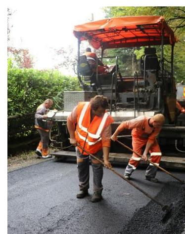
Prije tri tjedna u naselju Pila uređene su i asfaltirane dvije nerazvrstane ceste. Ukupna površina novih asfaltiranih površina iznosila je 3220 četvornih metara. Spomenutim radovima prethodili su radovi rekonstrukcije i izgradnje kanala oborinske odvodnje čime su ovi dijelovi naselja potpuno opremljeni komunalnom infrastrukturom. Ukupna vrijednost investicije iznosila je više od 580 tisuća kuna. (mlm) ■
